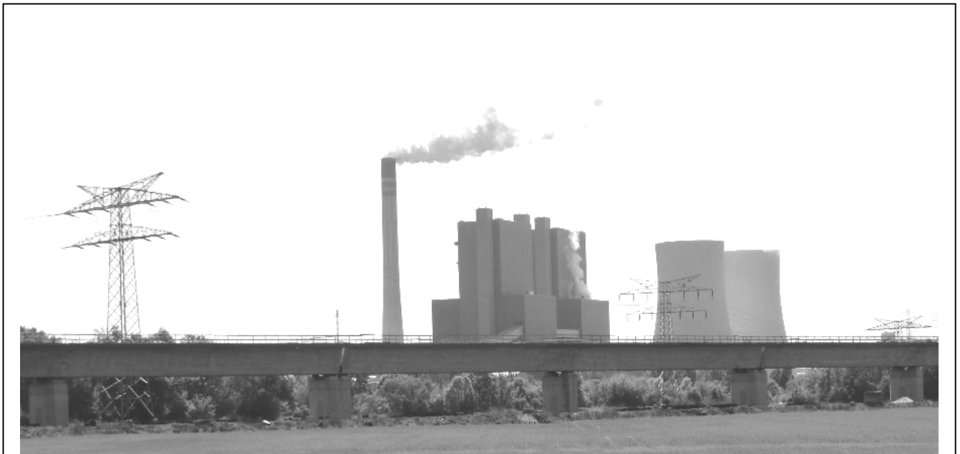
Im Kraftwerk in Schkopau werden jedes Jahr aus 6 Mio. Tonnen Braunkohle 900.000 kW Strom
